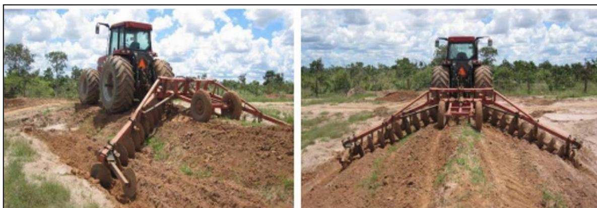
Figura 217 - Construção de terraço de base larga com arado terraceador
