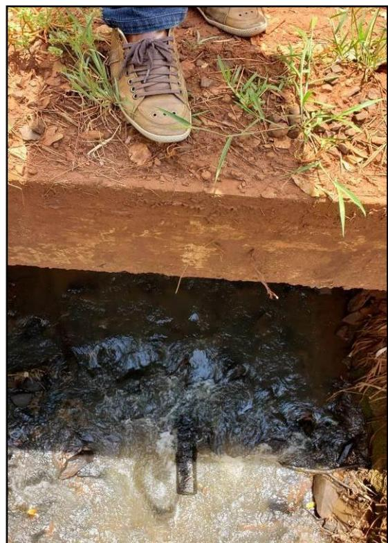
Figura 143 – Ausência de guarda corpo
