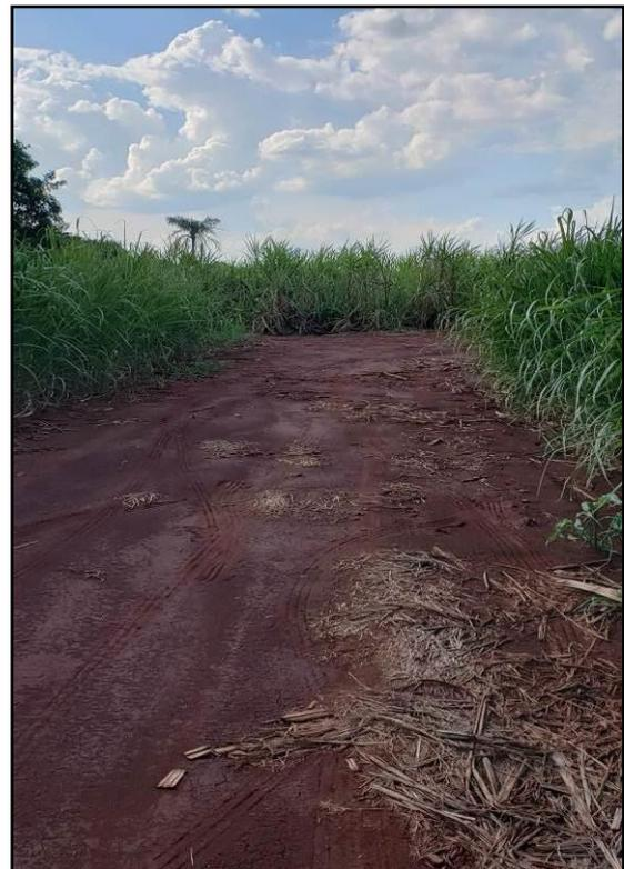
Figura 177 – Erosões vindas do carreador.
