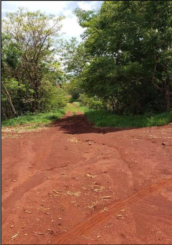
Figura 134 – Erosão na estrada.
