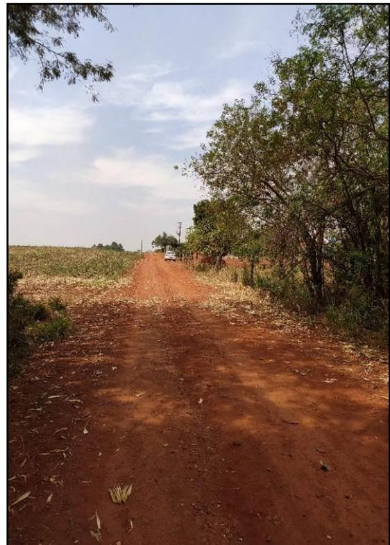
Figura 82 – Ausência de revestimento.
