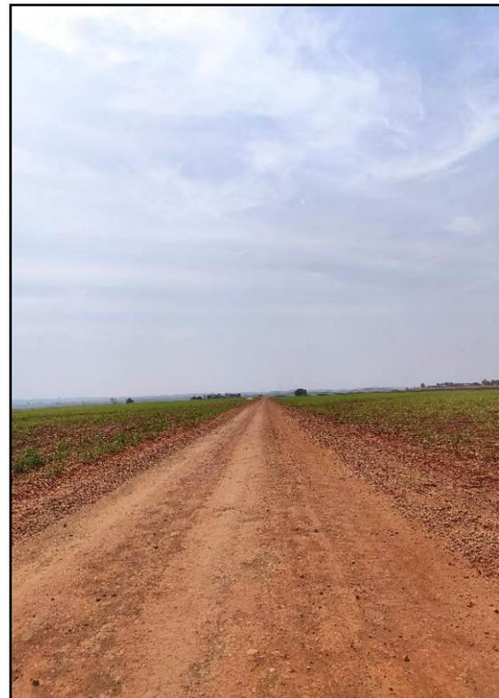
Figura 90 – Sem saída d'água.
