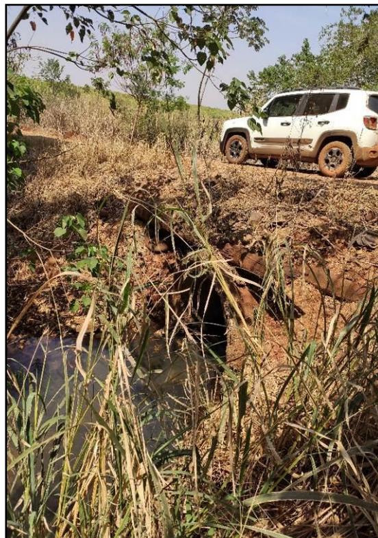
Figura 74 – Tubulação de 1,5m e concreto.
