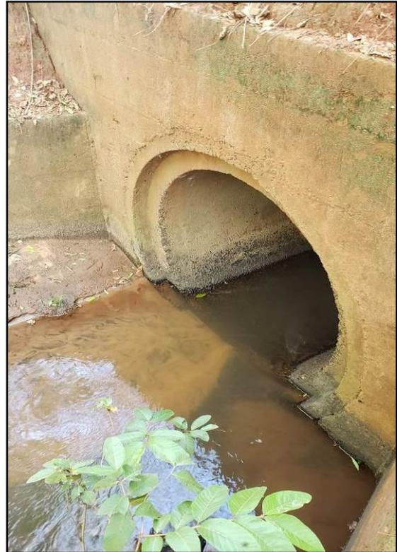
Figura 183 – Tubulação 2 m de concreto.
