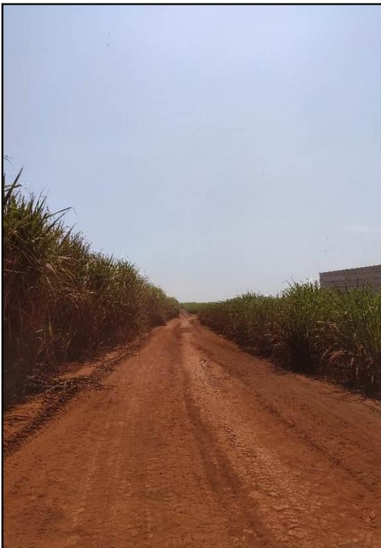
Figura 67 – Plataforma não conformada.
