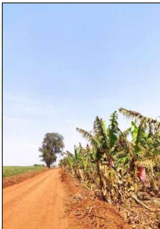
Figura 70 – Estrada sem saída d'água.
