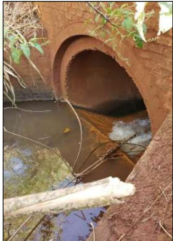
Figura 187 – Tubulação 1,5 m de concreto.
