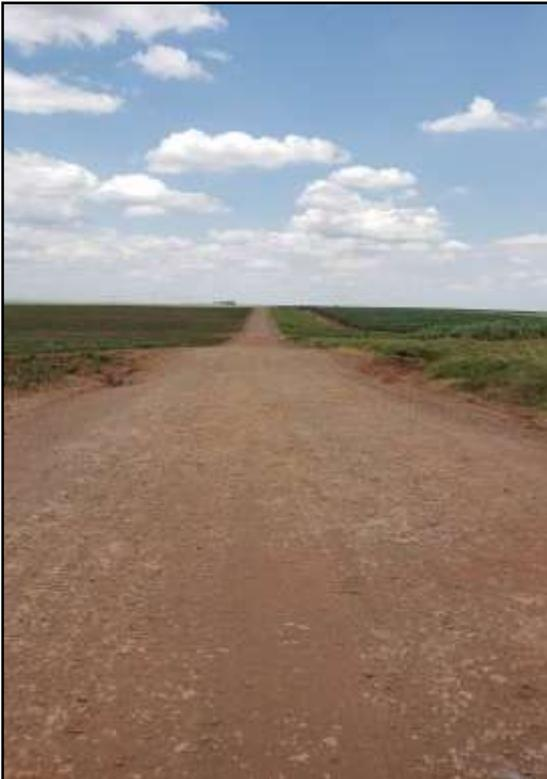
Figura 148 – Revestimento com cascalho.
