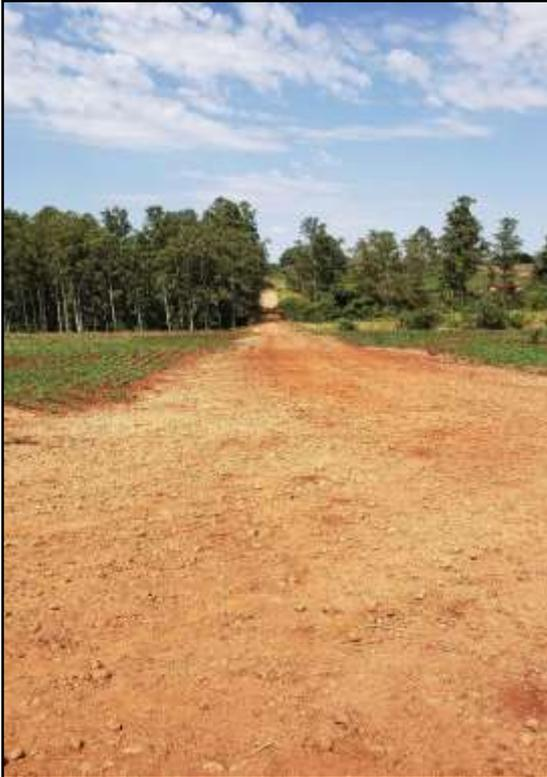
Figura 116 – Revestimento com cascalho.
