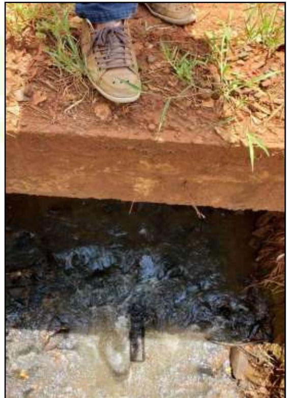
Figura 143 – Ausência de guarda corpo
