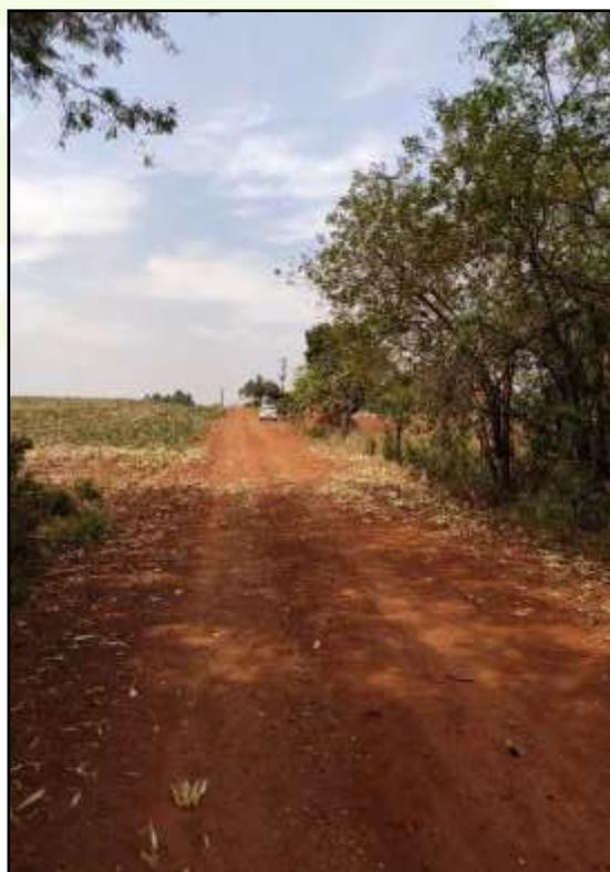
Figura 82 – Ausência de revestimento.
