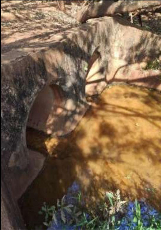
Figura 45 – Duas tubulações de 1 m.
