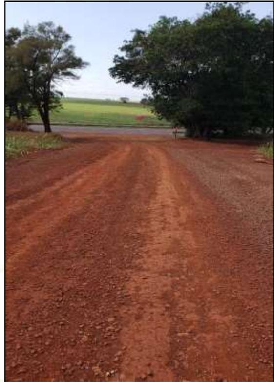
Figura 115 – Revestimento com cascalho.
