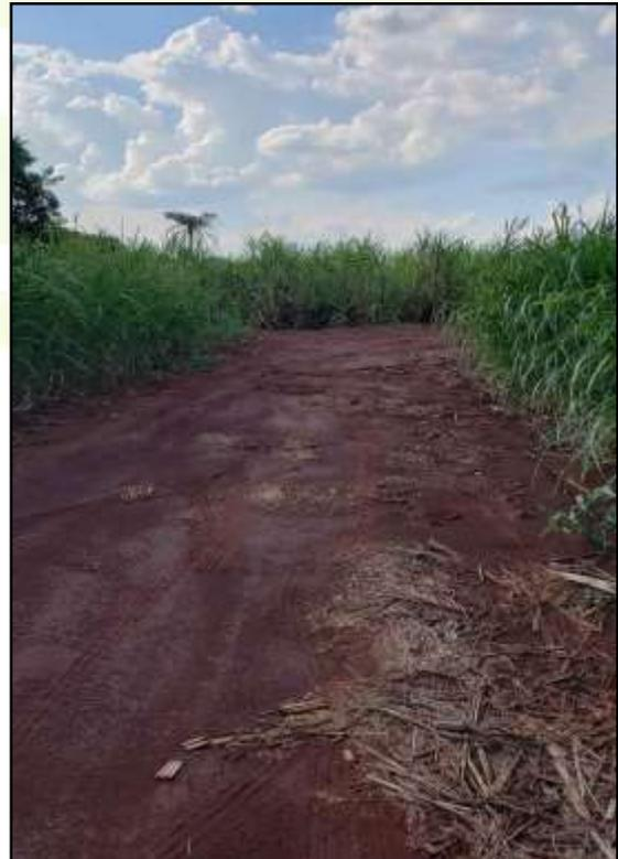
Figura 177 – Erosões vindas do carreador.
