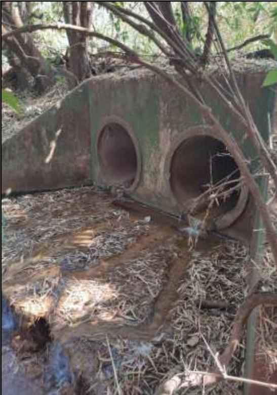
Figura 46 – Duas tubulações de 1 m.
