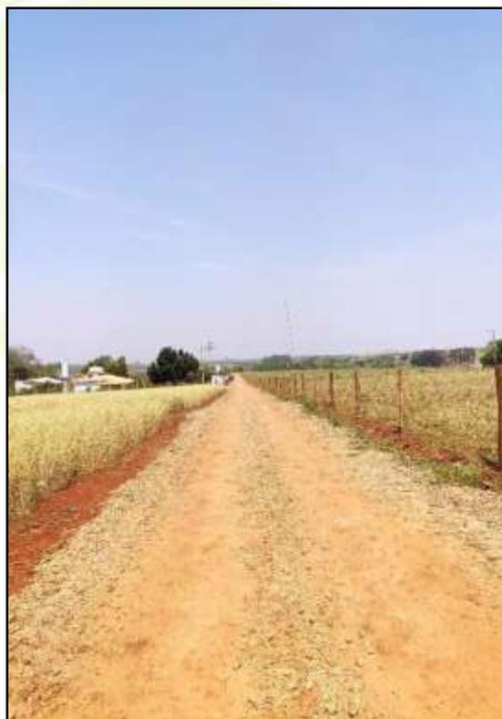
Figura 72 – Revestimento de cascalho.
