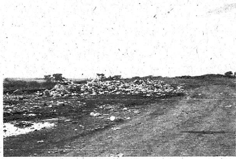
Aterro Sanitário do Município de Cândido Mota
