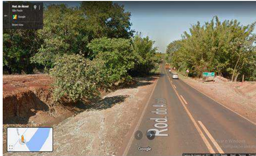
Foto – Vista frontal da Rodovia do Alcoól
